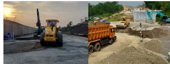
Gambar 2. Suasana Pelaksanaan Proyek Subgrade
