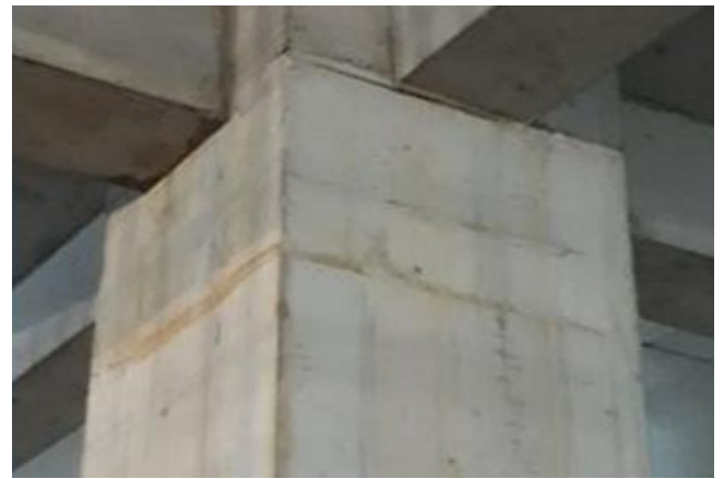
Gambar 14. Hasil Pengecoran Bekisting Konvensional
