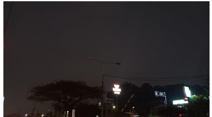
Gambar 4. Kondisi Kerusakan Lampu Penerangan Jalan
