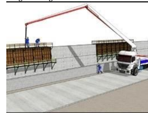
Gambar 9. Pengecoran segmen dinding
