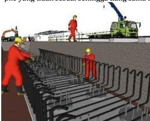
Gambar 3. Pemotongan kepala tiang bore pile
