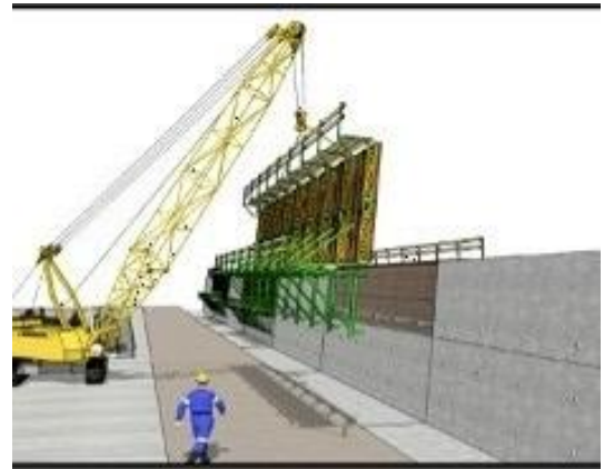
Gambar 5. Pemasangan bekisting pile cap
