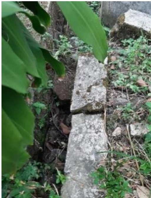
Gambar 1. Kondisi saluran eksisting.
