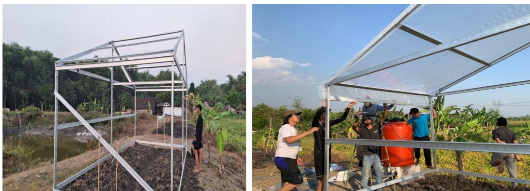
Gambar 3. Proses Pembuatan Green House dan Instalasi Irigasi Tetes untuk Penanaman Semangka Sumber: Kegiatan Pengabdian kepada Masyarakat (2023)
