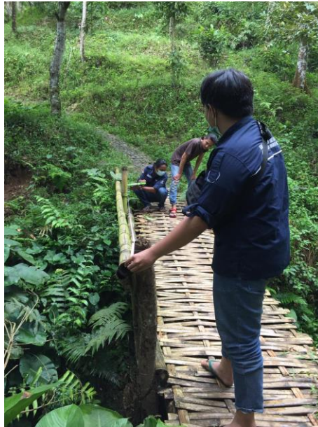
Gambar 3.2 Mengukur Panjang Pegangan Jembatan
