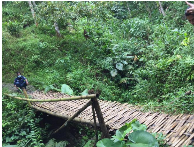
Gambar 3.1 Mengukur Panjang jembatan
