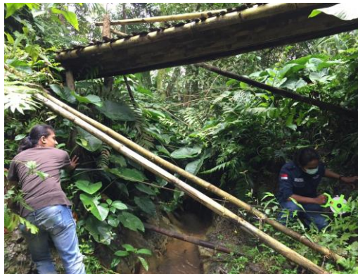
Gambar 3.3 Mengukur Panjang Pondasi Jembatan
