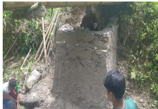
Gambar 6. Pelaksanaan pekerjaan pondasi Gambar 7. Pekerjaan abutment jembatan
