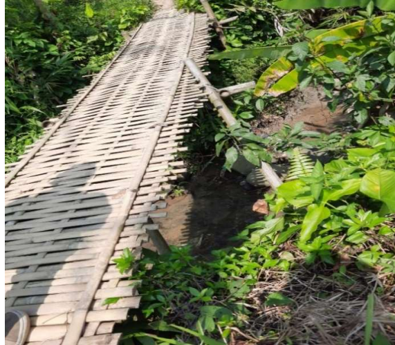
Gambar 1. Jembatan Desa Pasir Karok
