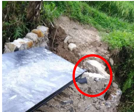
Gambar 11. Pada bawah jembatan dilakukan pemasangan bantalan ban bekas yang berfungsi sebagai perletakan untuk jembatan
