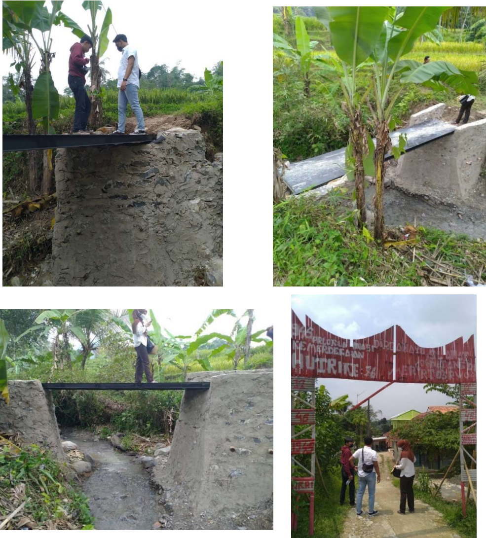
Gambar 12. Peninjauan konstruksi jembatan
