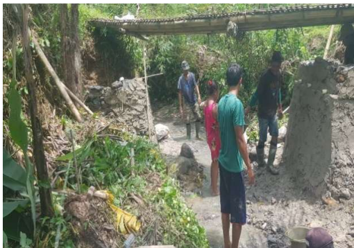
Gambar 6. Pelaksanaan pekerjaan pondasi Gambar 7. Pekerjaan abutment jembatan
