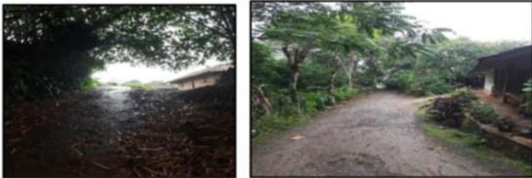
Gambar 3 Kondisi jalan dan belum adanya penerangan jalan menuju masjid
