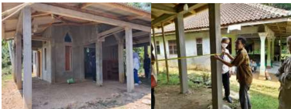
Gambar 4. Pengukuran Selasar Mushola untuk Pemasangan Keramik
