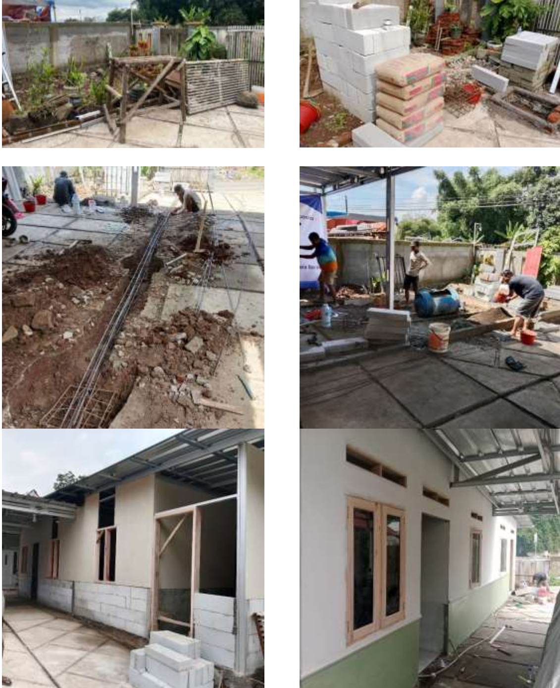
Gambar 9. Proses Konstruksi Klinik Bidan
