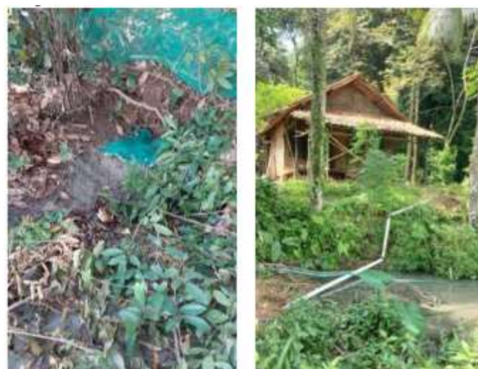
Gambar 5. Perbaikan pada Mata Air
