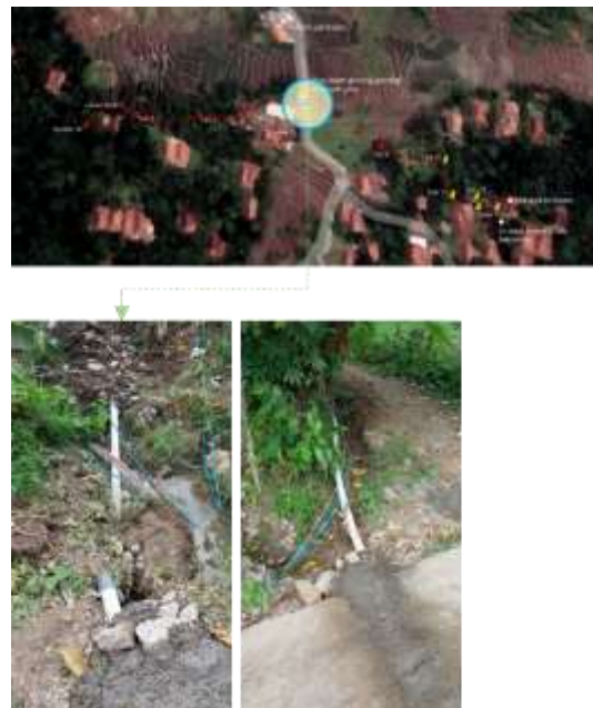
Gambar 7. Pekerjaan Pemasangan Pipa pada Perpotongan Jalan
