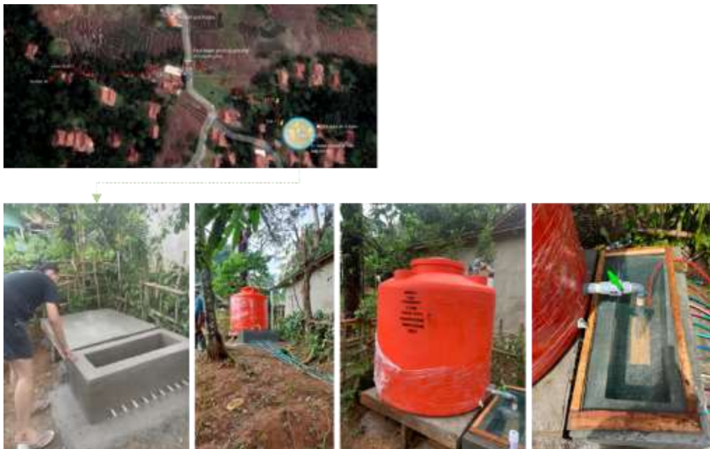
Gambar 8. Pekerjaan Pemasangan Pipa Bagian-2 dan Pembuatan Bak Kontrol
