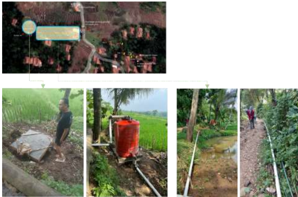
Gambar 6. Pekerjaan Pemasangan Pipa Bagian-1
