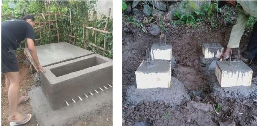
Gambar 5. Pembuatan bak kontrol dan pondasi
