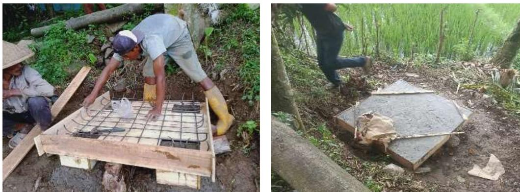
Gambar 4. Pembuatan alas bak penampungan
