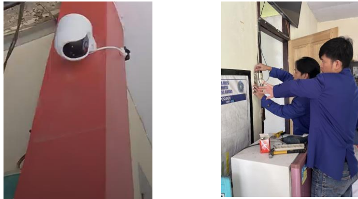
Gambar 1. Instalasi Listrik dan Pemasangan CCTV
