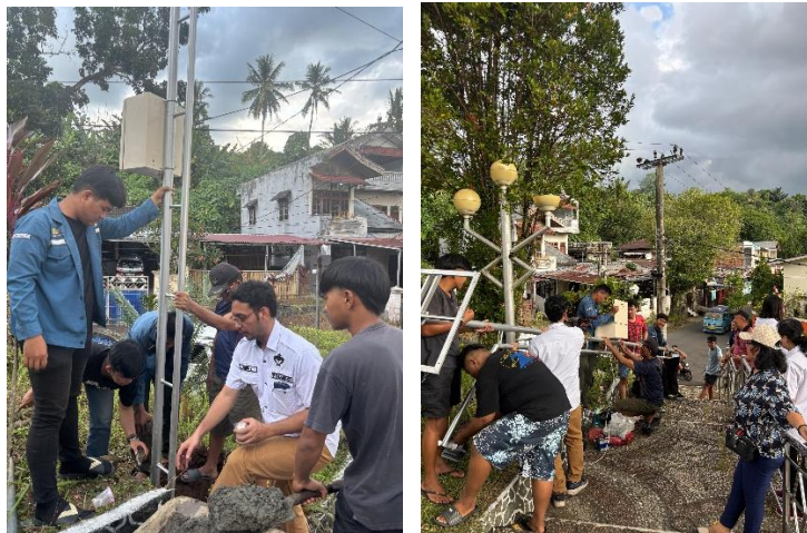
Gambar 2. Proses penginstalan sistem penerangan berbasis PLTS di lokasi tangga Gereja
