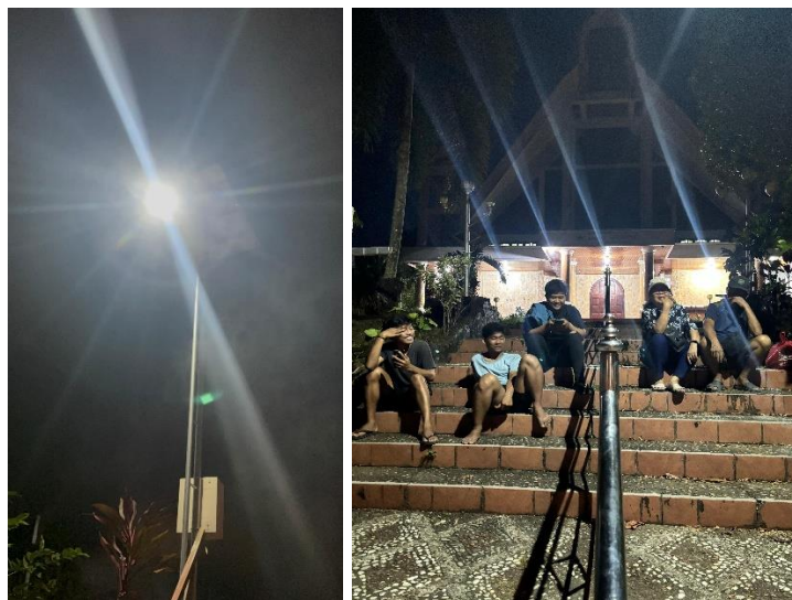
Gambar 2. Hasil pemasangan dan penerangan tangga Gereja di malam hari
