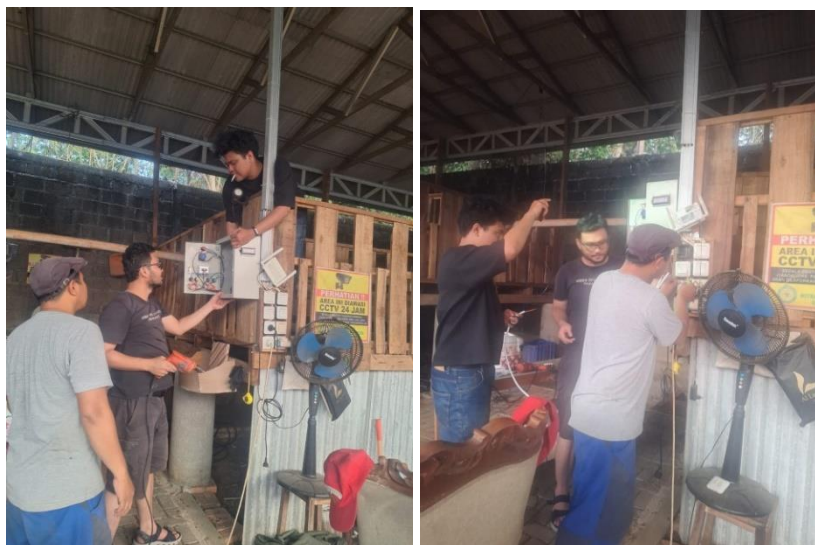
Gambar 6. Pemasangan sistem monitoring kandang cerdas
