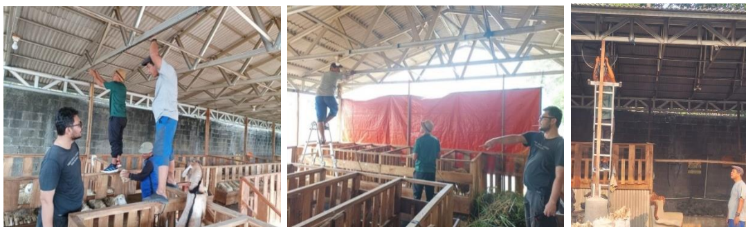
Gambar 5. Pemasangan Sensor Suhu, Cahaya Dan Gas Amonia
