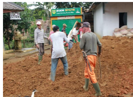
Gambar 4. Pekerjaan pengadaan tanah timbunan dan meratakan tanah pada area yang akan diperbaiki
