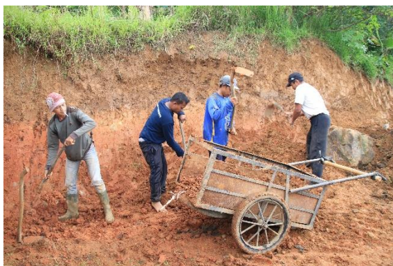
Gambar 4. Pekerjaan pengadaan tanah timbunan dan meratakan tanah pada area yang akan diperbaiki
