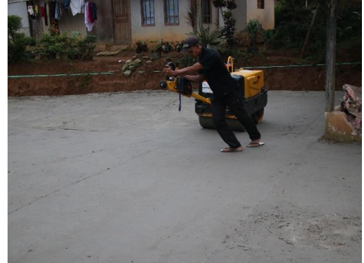
Gambar 6. Proses perataan campuran dan Pematatan jalan dengan menggunakan baby roller
