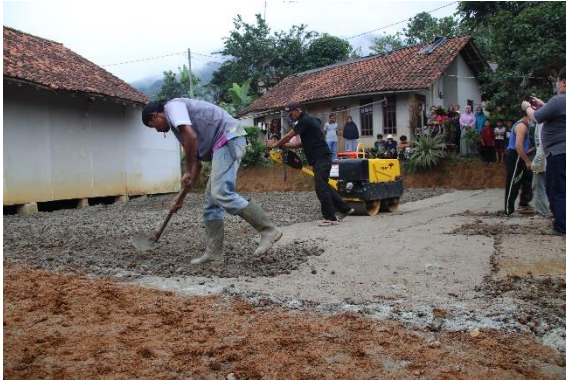
Gambar 6. Proses perataan campuran dan Pematatan jalan dengan menggunakan baby roller
