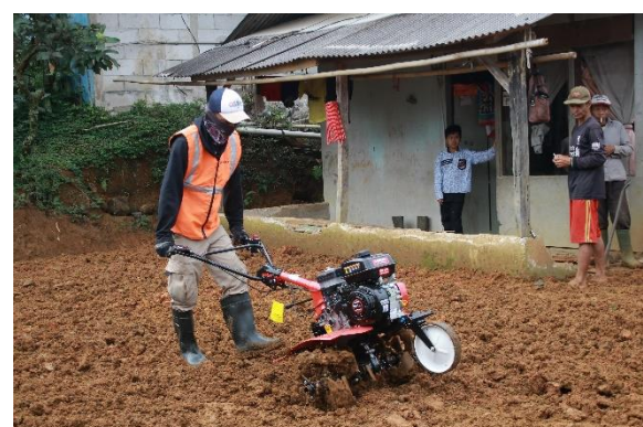
Gambar 5. Proses pencampuran tanah dengan semen dan soil stabilizer menggunakan alat cultivator
