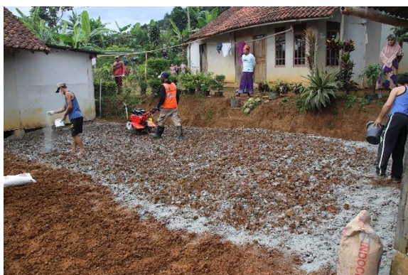
Gambar 5. Proses pencampuran tanah dengan semen dan soil stabilizer menggunakan alat cultivator
