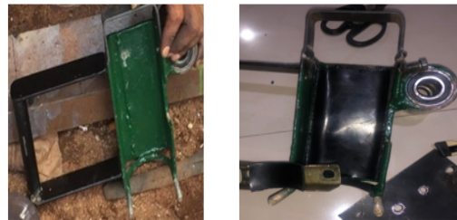
Gambar 14. Proses pemasangan karet
