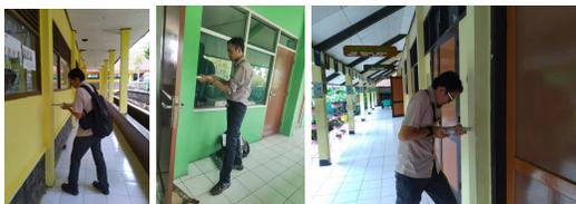
**Gambar 12.** Hammer Test pada Bangunan Gedung Sekolah
