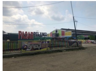
Gambar 16 Kondisi Eksisting Main Entrance Pasar Pelangi
