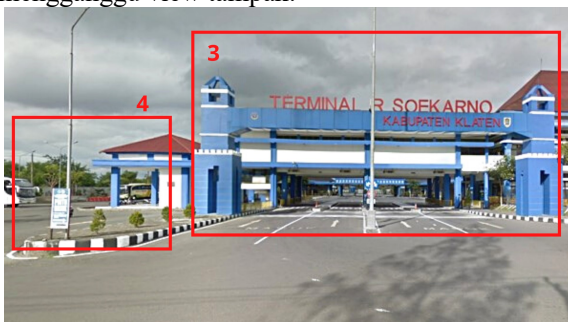
Gambar 8. Tampak pada Area Entrance Bus Terminal
