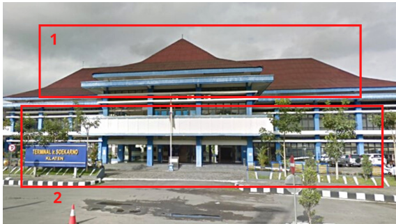
Gambar 7. Tampak Existing Bangunan Utama
