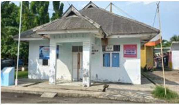
Gambar 8. Bangunan penunjang PPI Kalianda
