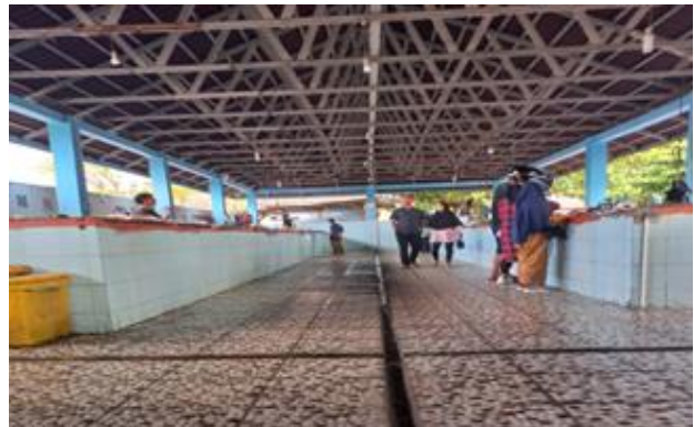
Gambar 7. Struktur atap kuda-kuda baja ringan.
