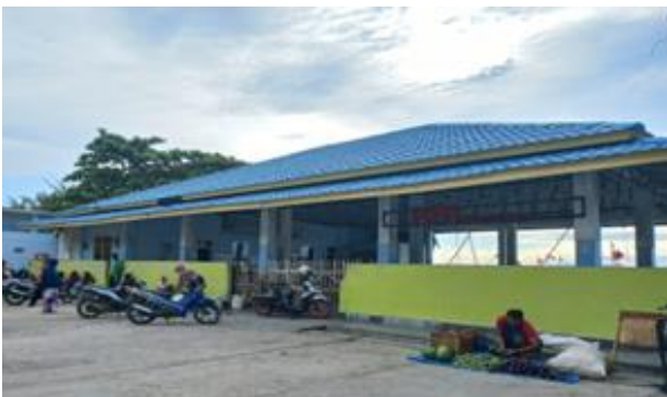
Gambar 5. Bangunan Tempat Pelelangan Ikan
