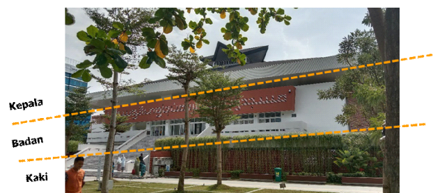
Gambar 4. Kaki, Badan, dan Kepala Bangunan Sumber: Dokumentasi (2024)
