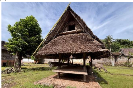
Gambar 2. Atap Bangunan Tradisional Bali di Desa Tenganan.
