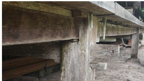
Gambar 11. Sistem struktur bawah Bale Banjar .
