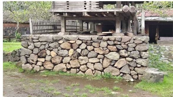
Gambar 7. Pondasi dengan teknik dry construction di Desa Tenganan, Bali.
