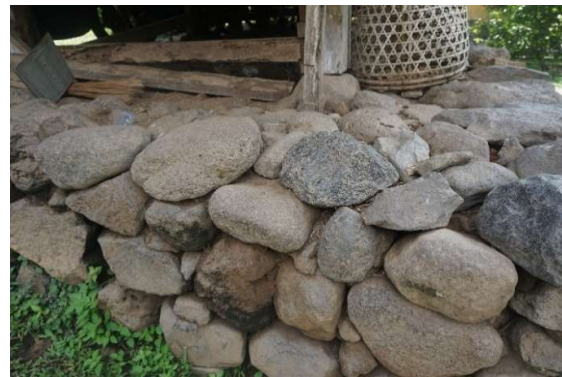
Gambar 13. Pondasi pada Bale Banjar.
