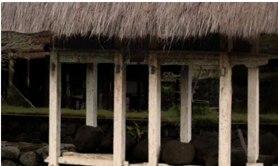
Gambar 3. Struktur Bangunan di Desa Tenganan. Sumber: Udaya Bali [7].
