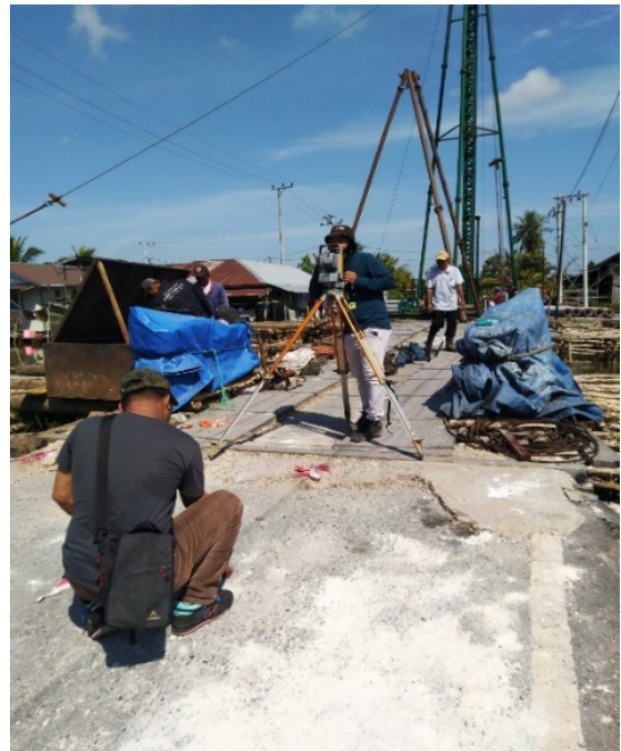
Gambar 3. Penentuan Titik Tiang Pancang
