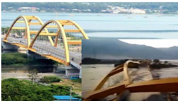
Gambar 1. Rubuhnya tiang jembatan di Palu akibat gempa Sumber: (Tribun, 2019)
