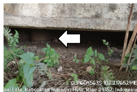
Gambar 3. Kondisi Karat pada Tiang Pancang
