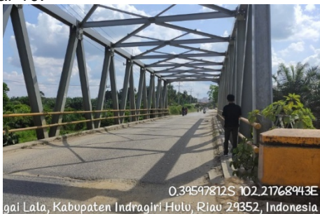
Gambar 10. Kondisi Marka Jalan
