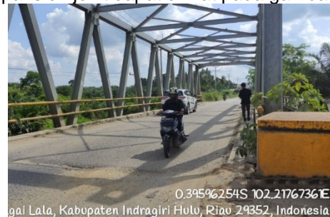
Gambar 7. Kondisi Sambungan atau Expansion Joint
