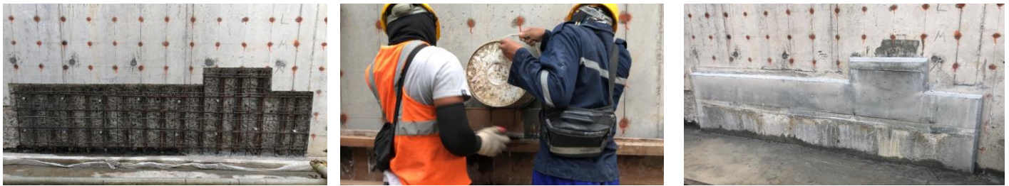
Gambar 7. Kategori 2 honeycomb dari 50 mm sampai 100 mm
