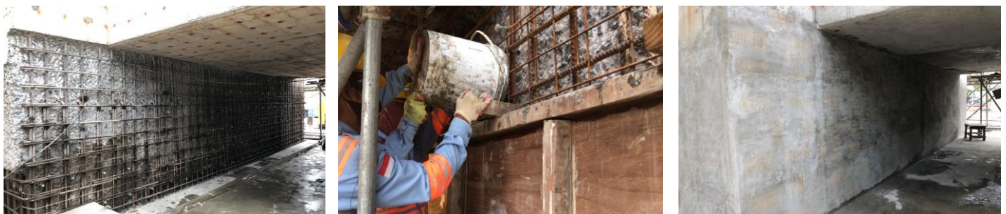
Gambar 8. Kategori 3 honeycomb over 100 mm
