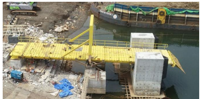
Gambar 2. Struktur Ramp door .
