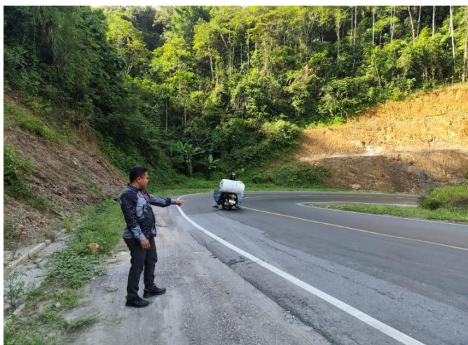
Gambar 5. Kondisi Jalan Kolaka – Kolaka Utara
