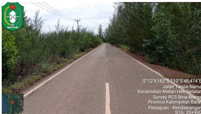
Gambar 2: Kondisi Sta. 20+900 Ruas Jalan Pesaguan-Kendawangan yang menunjukkan kondisi excellent
