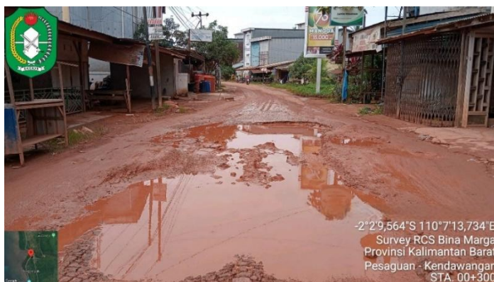
Gambar 1: Kondisi Sta. 00+300 Ruas Jalan Pesaguan-Kendawangan yang menunjukkan kerusakan parah
