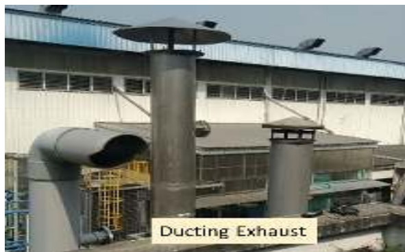
Gambar 2. Lokasi pengukuran debit gas buang.
