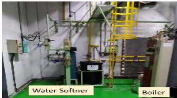
Gambar 1. Tata letak boiler dan softner
